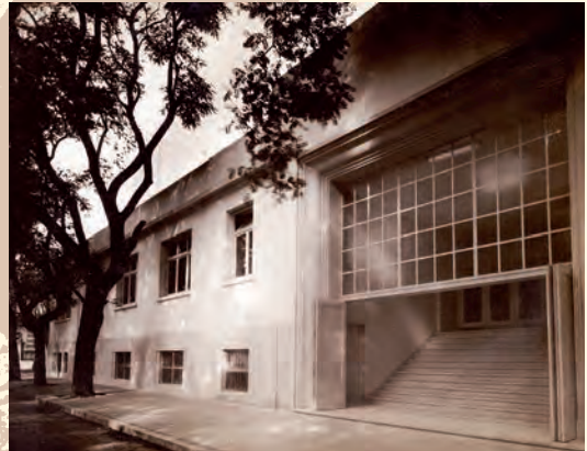
Entrada del Colegio en la década del 60.
